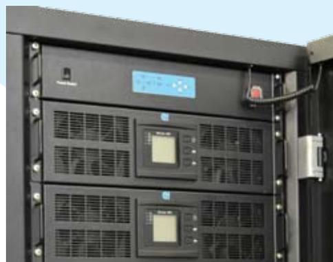
Источники бесперебойного питания СИП380А МД модульного типа удовлетворяют самым современным требованиям в области электропитания критически важного оборудования. Модульная архитектура гарантирует высокую надежность, гибкость и ремонтпригодность системы.
